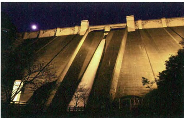
常用洪水吐からの越流(毎秒約3立方メートル)
