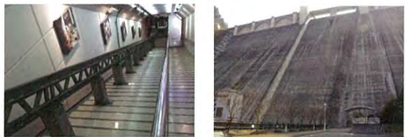
▲C 階段にも、写真が展示されています。 ▲C 堤体下左岸側にある監査廊の入り口。
