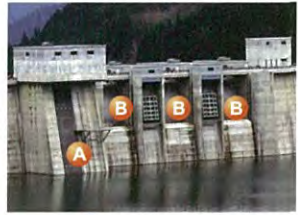
▲A 選択取水設備 B 非常用洪水吐
