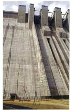
▲C 堤体下右岸にある監査廊の入り口
